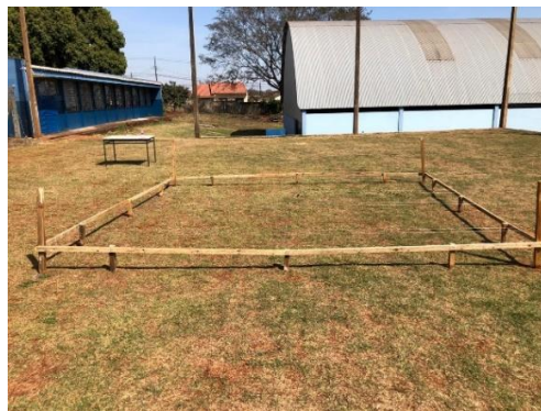
Figura 2 – Gabarito de locação construído na escola.
