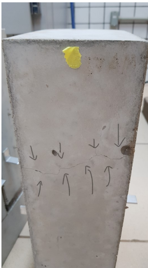
Figura 2 – Fissura observada no corpo de prova de três estribos
