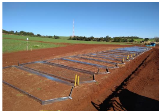
Figura 2 – Instalação das calhas
