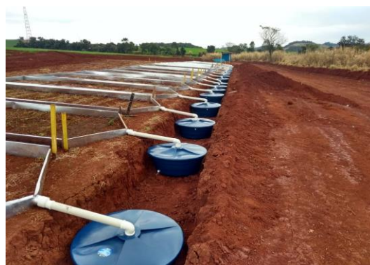
Figura 3 – Instalação dos canos e caixas d'água
