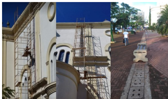
Figura 8. Reforma Corretiva realizada em 2016.
