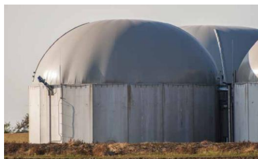
Figura 4 – Biodigestor CSTR de uma planta de biogás.
