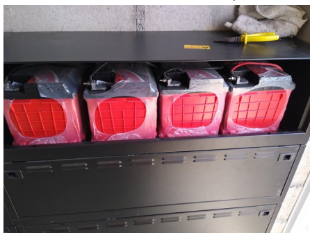
Figura 2 – Banco de Baterias aberto para visualização
